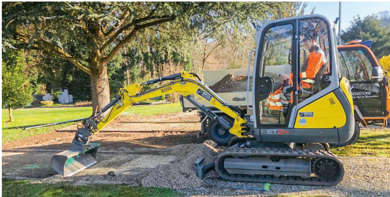
Jonas Klaiber bei Baggerarbeiten auf dem Friedhof
