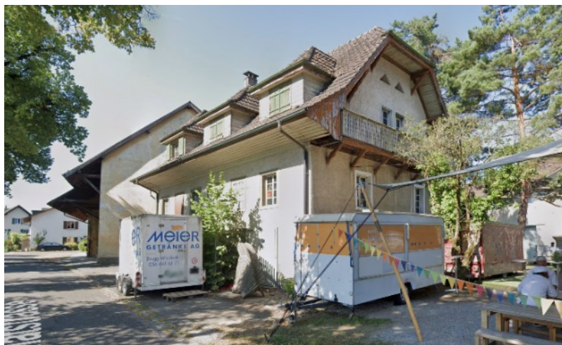
Abbildung 28: Gebäude Nr. 16 (Quelle: Google StreetView)
