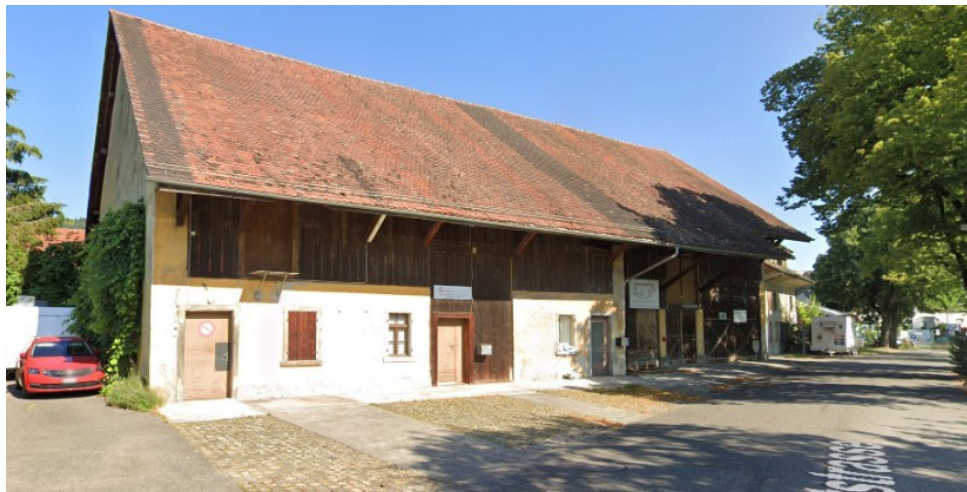
Abbildung 27: Gebäude Nr. 17 (Quelle: Google StreetView)
