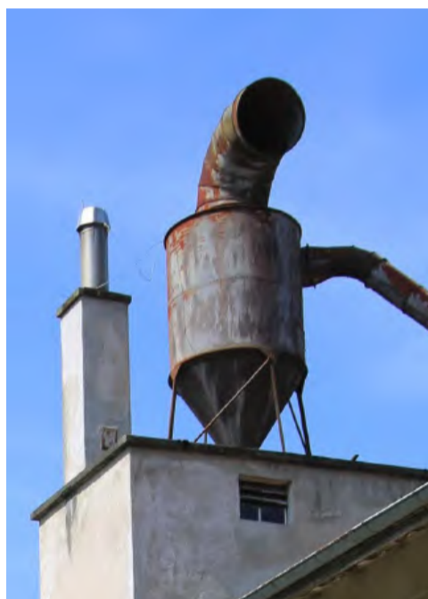
Abb. 3 Absauganlage (Giesserei)
