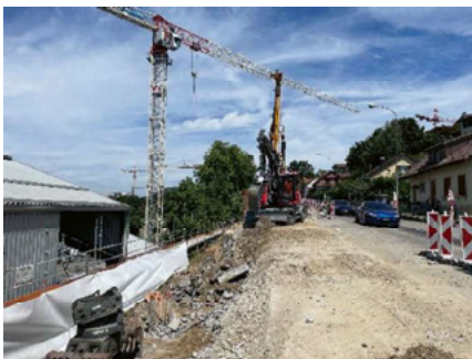
Baugrubenaushub
