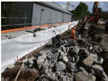
Rückbau bestehende Stützkonstruktion
