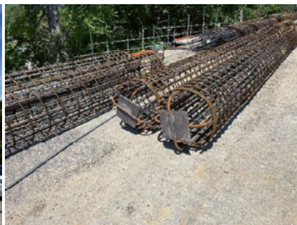
Grundplatten an Pfahlbewehrung
