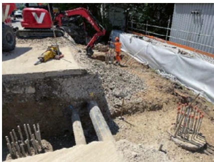
Pfahlkopfbearbeitung mit Unterlagsbeton für Fundamentriegel
