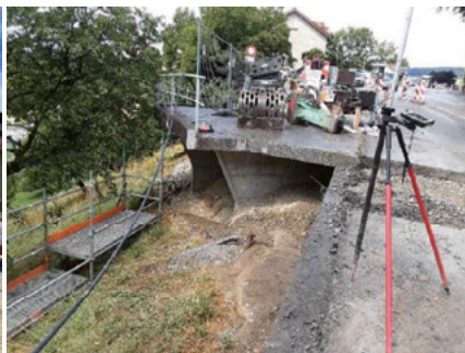
Trennschnitte und Rückbau Troller
